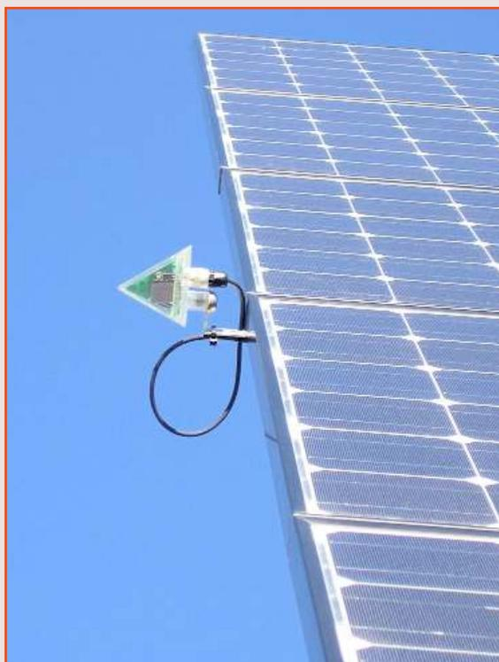
\* Detalle de una placa solar fotovoltaica con sensor de seguimiento
